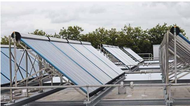
Das System HEAT-X Solar basiert auf Vakuumröhrenkollektortechnologie.
